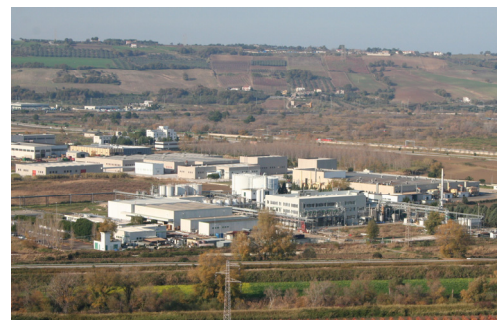
Stabilimento di Termoli (CB)
